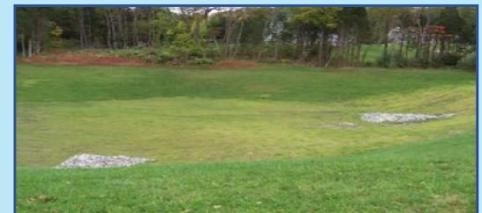
Figura 3. Ejemplo de estanque de detención, donde la entrada y salida del agua están protegidas con grava para evitar la erosión del suelo.
