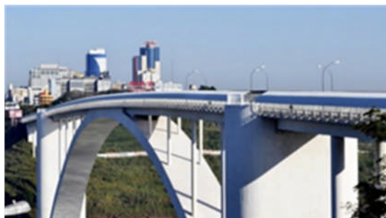
Figura 29. Vista del Puente de la Amistad después de la remodelación de 2015
