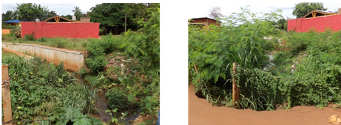
Figura 25. Final de la canalización del arroyo Tacuara y efecto del impacto del agua sobre el asfalto
