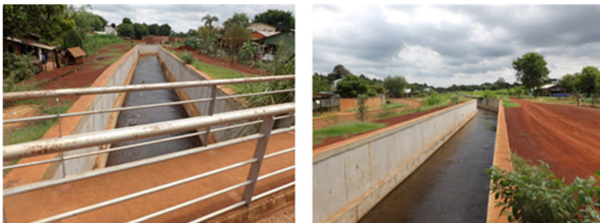
Figura 24. Agua de la corriente del Tacuara y puente sobre el canal.
