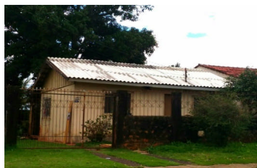
(b) Construcción de mampostería regular con techo doble agua y las baldosas de fibrocemento, Foz do Iguaçu.
