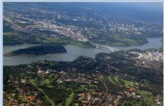
Ponte da Amizade, une Ciudad del Este e Foz do Iguaçu. Fonte: Paola Sakai
